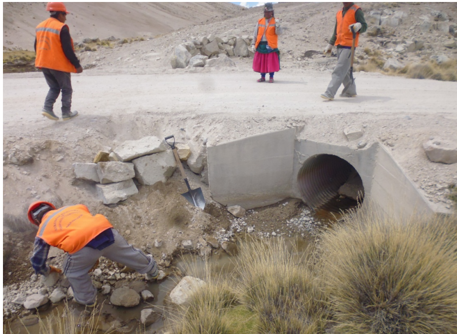
LIMPIEZA DE ALCANTARILLAS KM. 114+580
