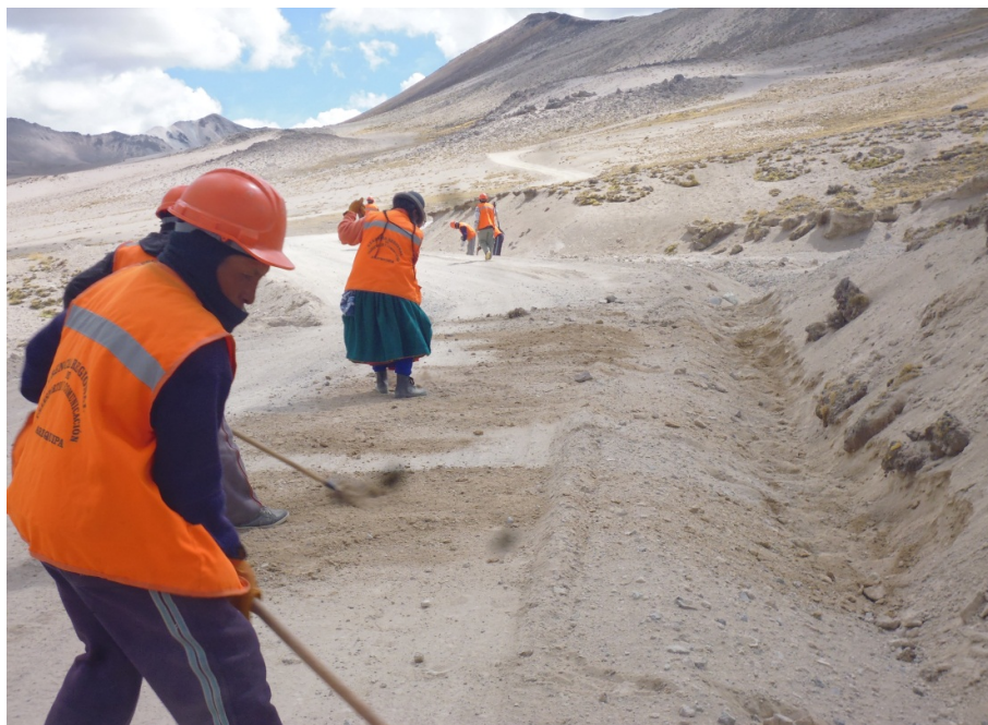
LIMPIEZA DE PLATAFORMA KM. 114+660
