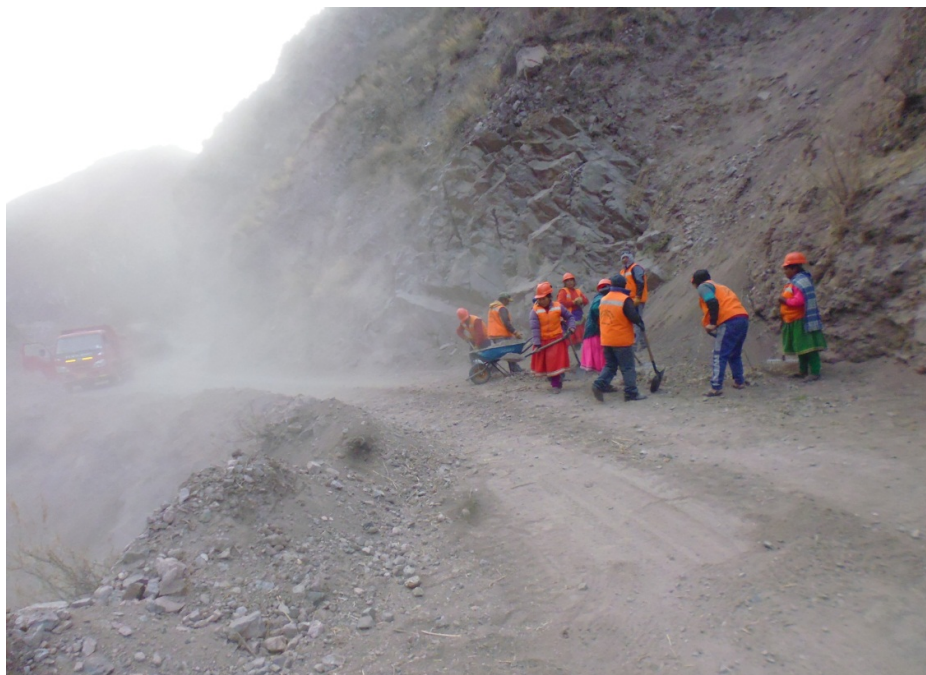
REMOCION DE PEQUEÑOS DERRUMBES KM. 118+300
