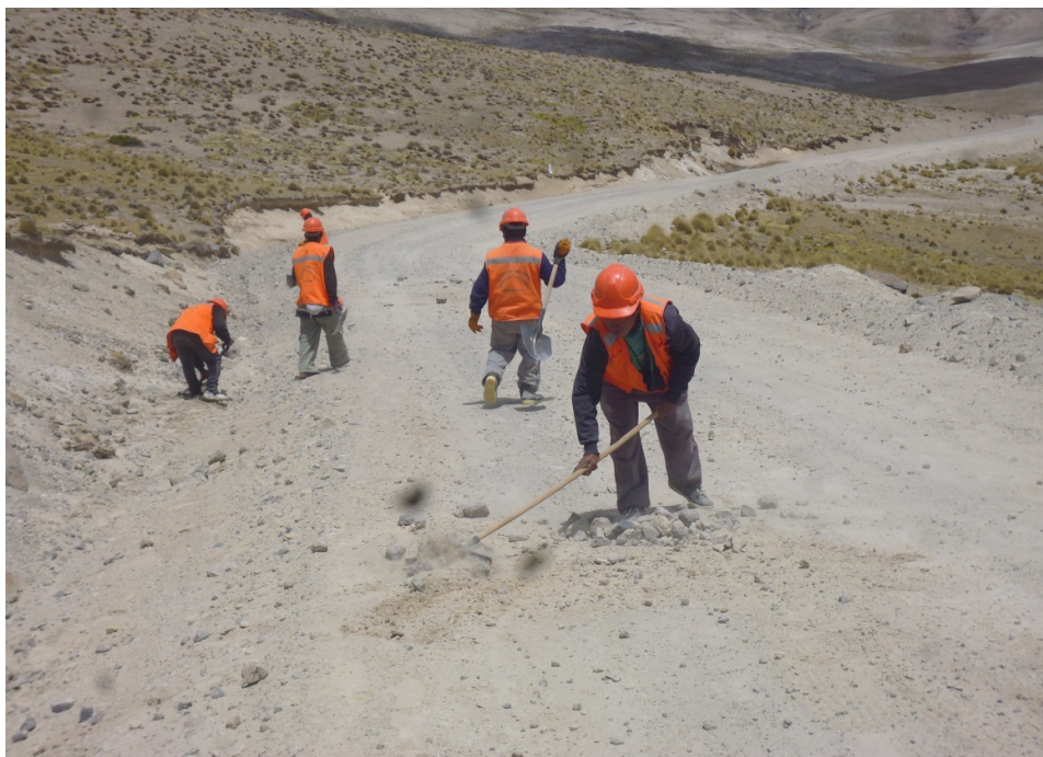
LIMPIEZA DE PLATAFORMA 118+500
