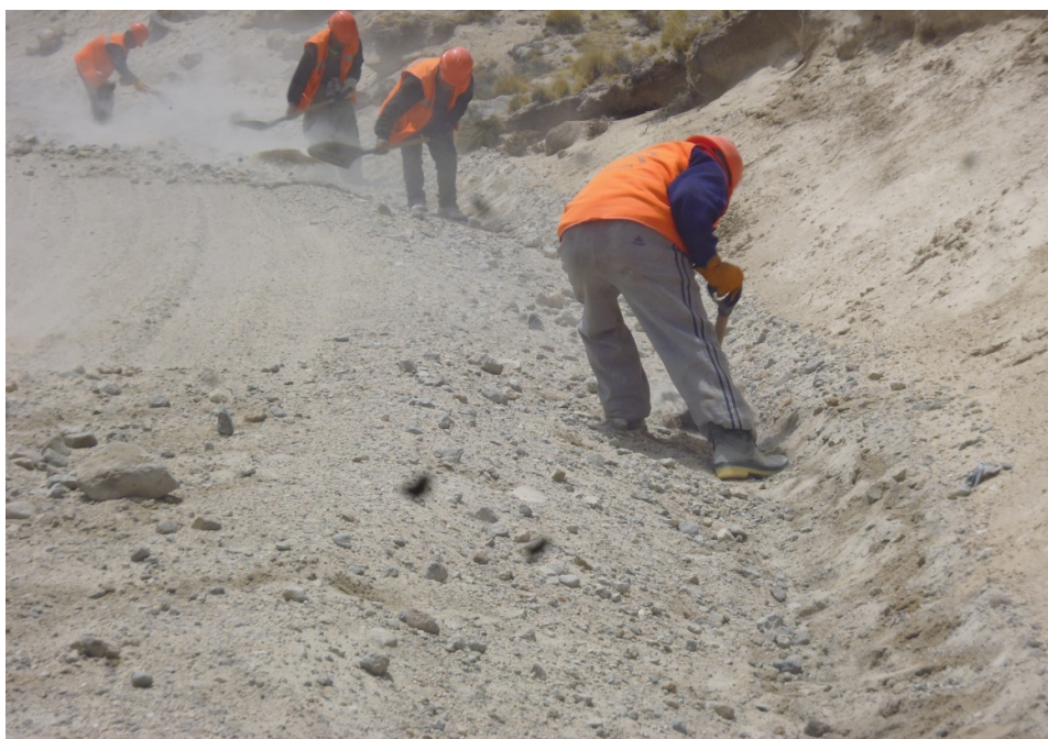
LIMPIEZA DE CUNETAS KM. 117+200
