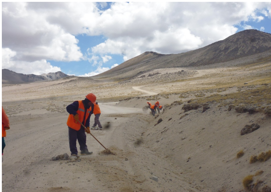
LIMPIEZA DE CUNETETA KM. 115+600
