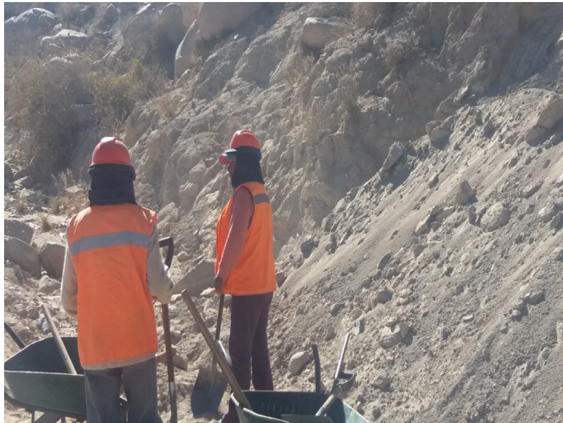
ELIMINACION DE DERRUMBES
