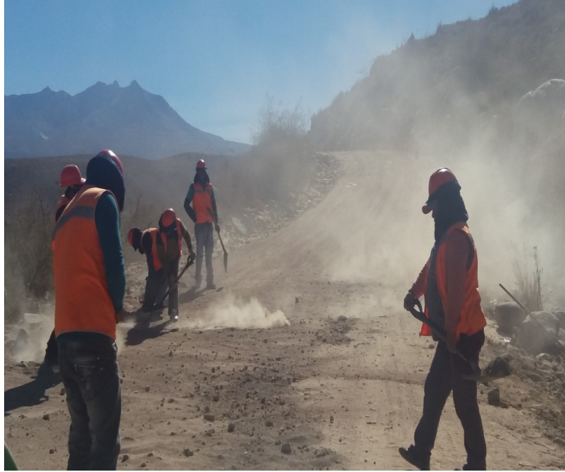
BACHEO DE PLATAFORMA
